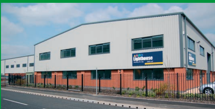
Lighthouse (UK) Ltd. Productiefaciliteit voor verbruiksartikelen
