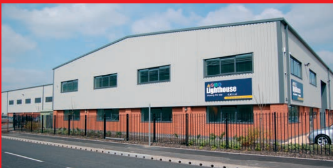
Lighthouse (UK) Ltd. Productiefaciliteit voor verbruiksartikelen
